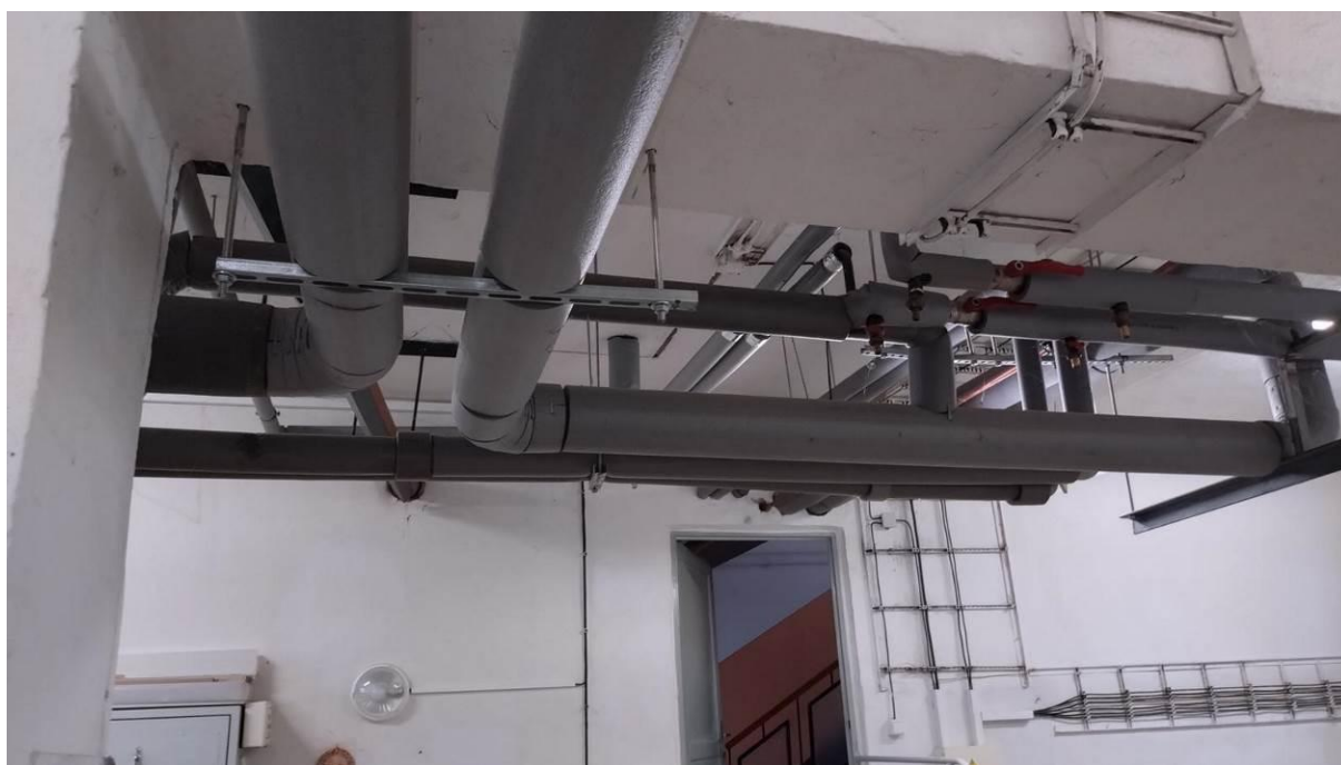
obr. 6 Vedení rozvodů do objektu pod stropem
