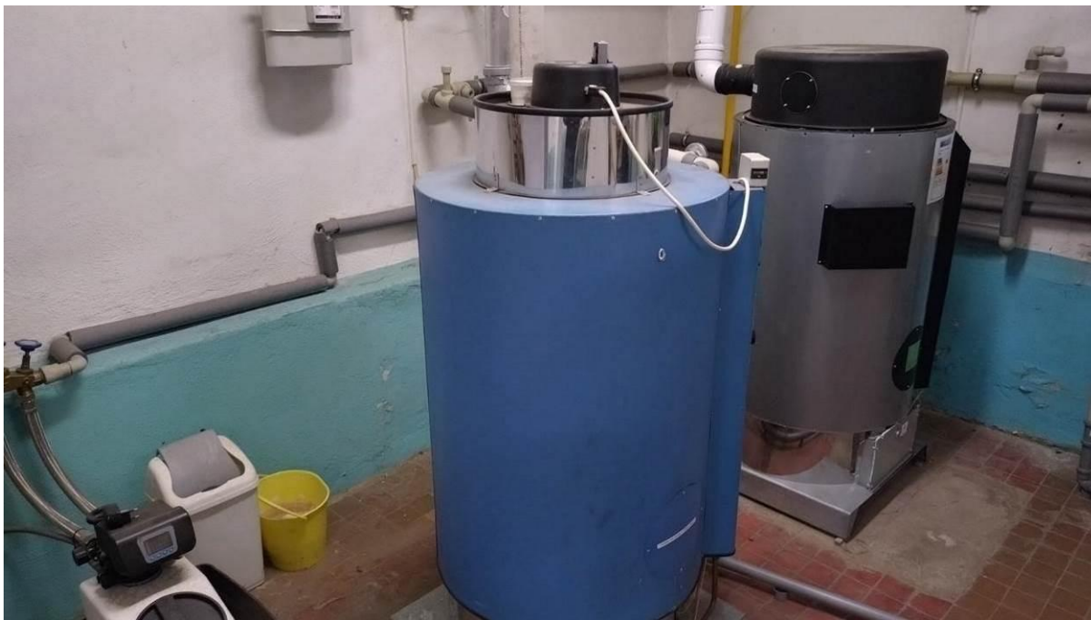
obr. 3 Pohled na plynové ohřivače teplé vody (v této správě nejsou hodnoceny)
